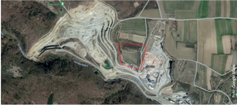
Rot markiert ist der Bereich, in dem die Baurestmassendeponie im Steinbruch entstehen soll.
