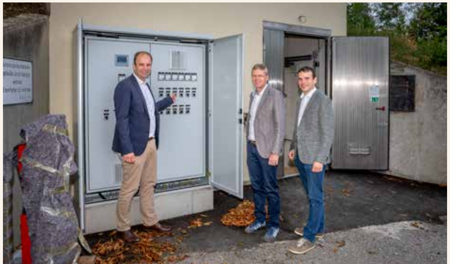
Bürgermeister Andreas Boigenfurst, Vizebürgermeister Wolfgang Falk, GR Johannes Döller bei der Wasseraufbereitungsanlage in Kühnring.
